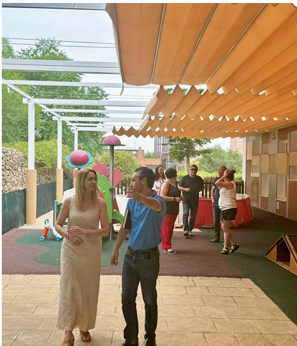
La concejala de Ciudad Lineal, Nadia Álvarez, visita las obras de la Escuela Infantil Las Azaleas
