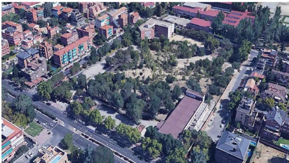
Vista aérea de la parcela del antiguo Hospital del Aire
